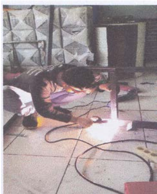
Gambar 17. Penyambungan Rangka (Sumber: Dokumentasi Pribadi)
