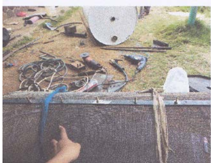
Gambar 18. Penyambungan Filter/Ram menggunakan Mur dan Baut (Sumber: Dokumentasi Pribadi)
