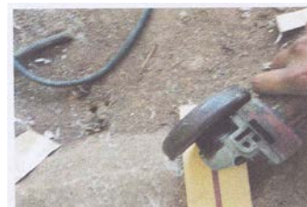
Gambar 15. Pemotongan Rubber Pad (Sumber: Dokumentasi Pribadi)
