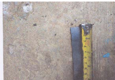
Gambar 11. Pengukuran Plat Strip (Sumber: Dokumentasi Pribadi)
