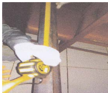
Gambar 5. Pengukuran Rangka (Sumber: Dokumentasi Pribadi)
