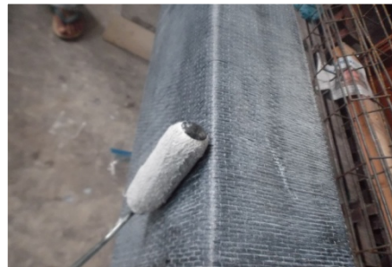
Gambar 5. Cara Pemakaian Carbon Wrapping jenis Sika Hex 231 C .
