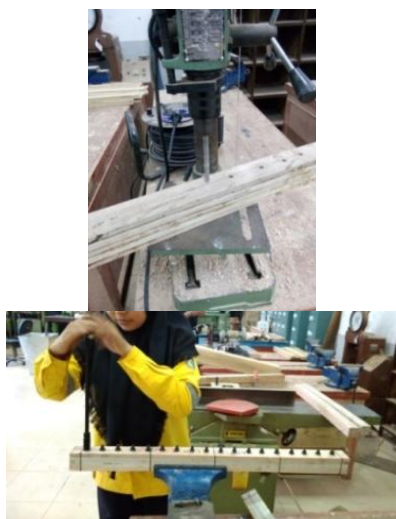
Gambar 3b. Proses pemasangan bahan perekat
