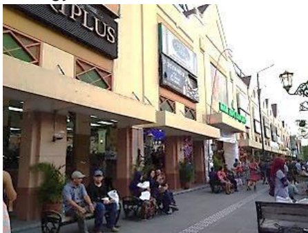
Gambar 1. Kondisi bagian depan Bangunan Malioboro Mall
