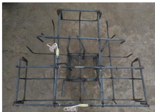
Gambar 5. Perakitan Baja Tulangan Metode Konvensional
