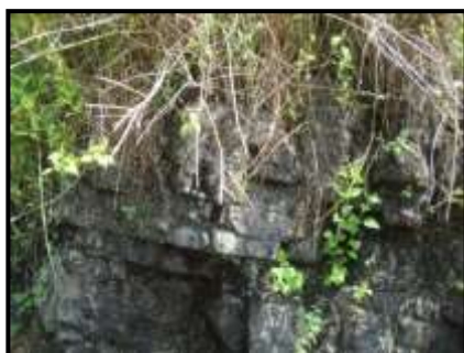
Gambar 9. Kenampakan andesit dengan struktur kekar berlembar (sheeting joint). Foto diambil di LP 86
