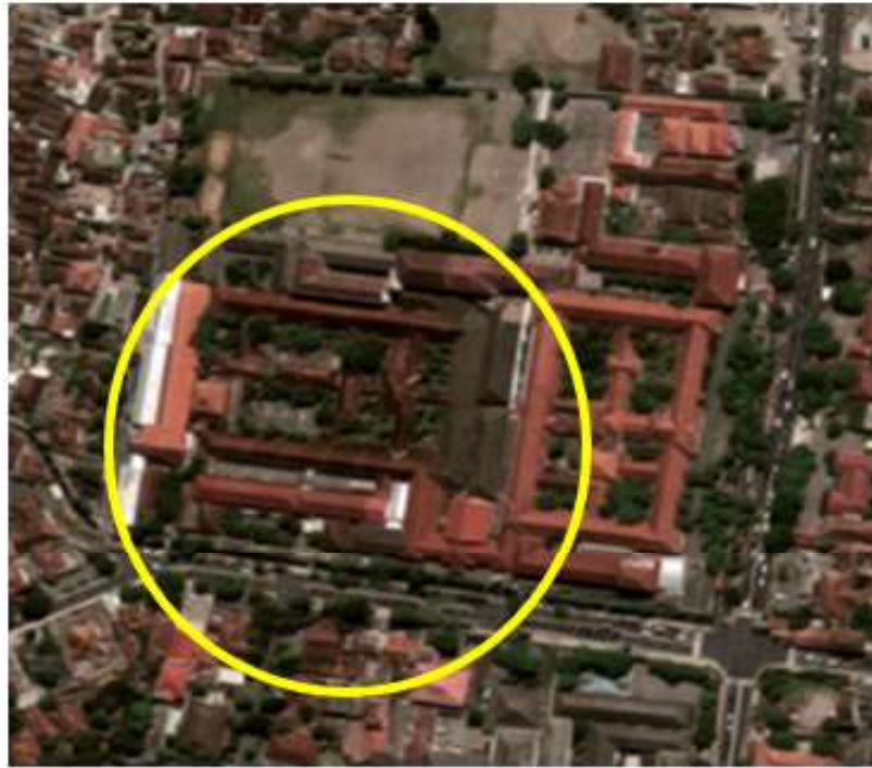
Gambar 2. Situasi Eksisting Bangunan
